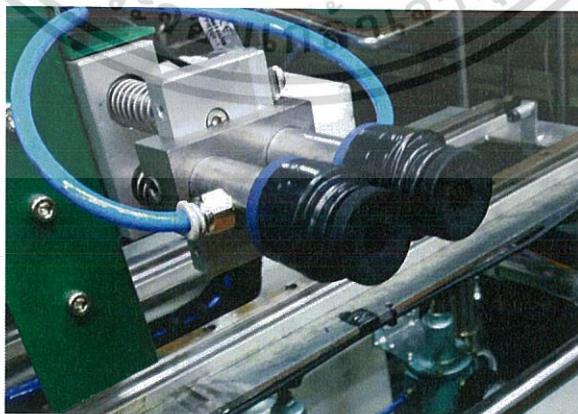
รูปที่ 4.5 หัวเป่ารูดอน้ำทิ้งหลังการแก้ไข (3)
