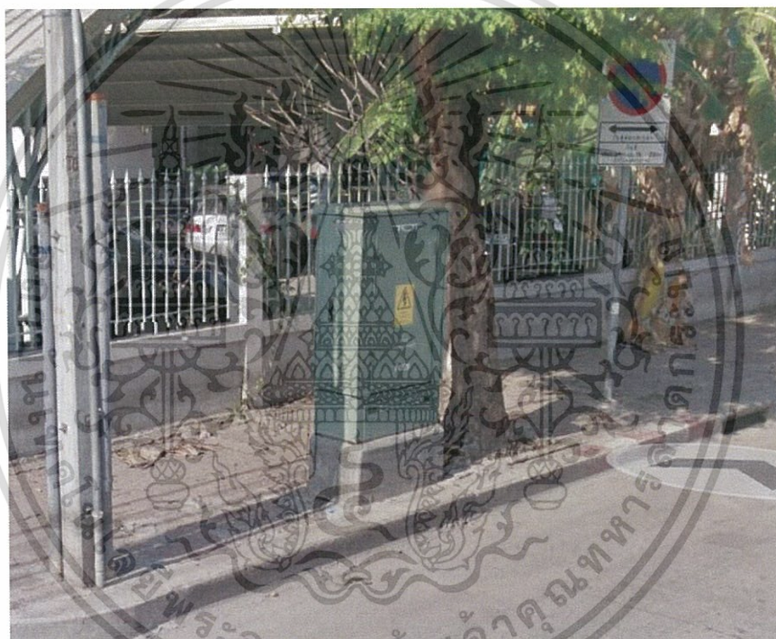
รูปที่ 3.1 ตู้ชุมสายโทรศัพท์ที่ใช้ทำการวัดอุณหภูมิ
