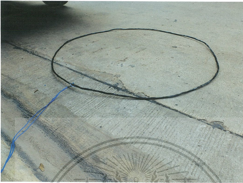
รูปที่ 4.9 Inductive Loop
