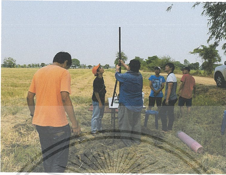
รูปที่ 4.46 การติดตั้งสถานีภาคพื้นดินในบริเวณที่ปล่อยบอลลูนตรวจอากาศ
