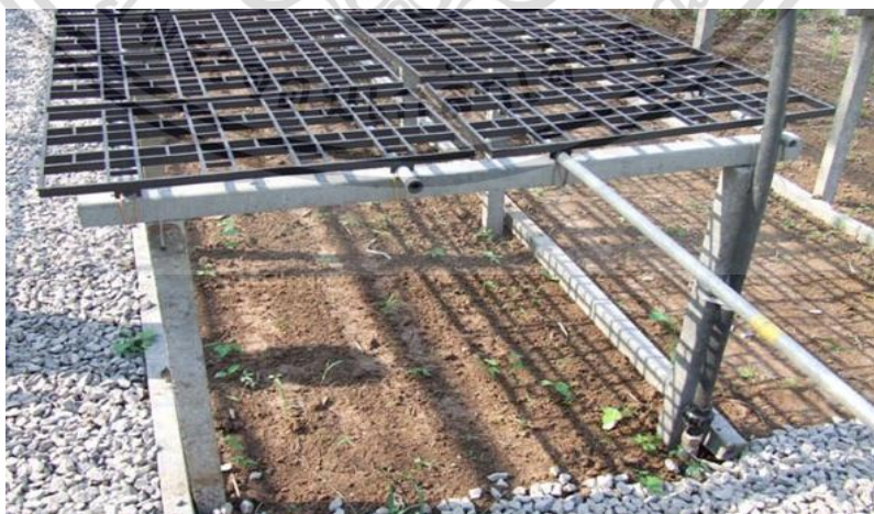
ภาพที่ 4.8 โตะวางต้นกล้วยไม้แบบใช้ท่อน้ำเหล็กเป็นแปพาดบนคาน
