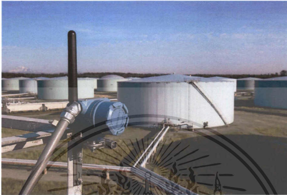
รูปที่ 3.3 ตัวอย่างการใช้งานอุปกรณ์ส่งสัญญาณแบบไร้สายกับระบบถังกักเก็บน้ำมัน
