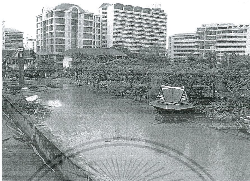
ภาพที่ 4.14 ลักษณะรูปทรงอาคารจากซ้ายไปขวา อาคารเรียนรวม 8 ชั้น อาคารเรียน 15 ชั้น และอาคารเรียนอเนกประสงค์ 9 ชั้น ความสูงเดิม 4 ชั้น ต่อเติมชั้นดาดฟ้าเพื่อขยายพื้นที่การเรียนการสอน รวมเป็นอาคารสูง 5 ชั้น
