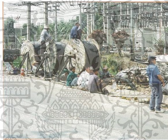
รูปที่ 4.27 แสดงการตั้ง REEL สายเคเบิลใต้ดินที่ปากบ่อ MANHOLE เพื่อติดตั้งสายเคเบิลใต้ดิน
