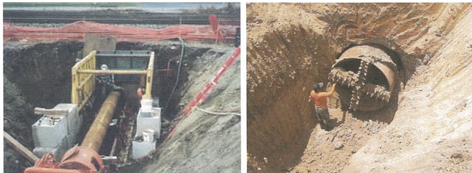
รูปที่ 4.13 Pipe Jacking
