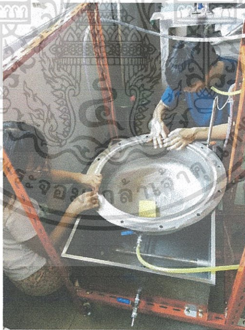
ภาพที่ ก.2.10 ติดตั้งปะเก็นฝาท่อสูญญากาศ
