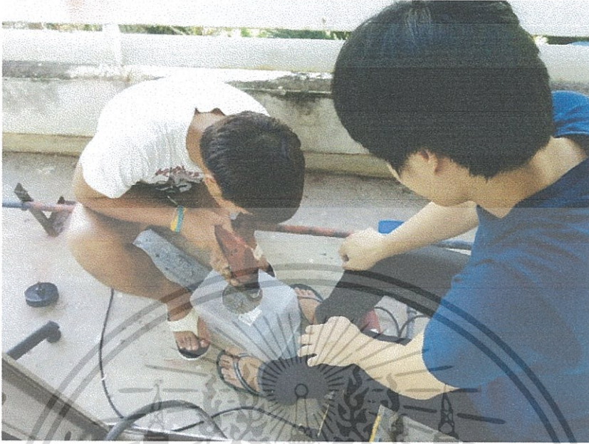
ภาพที่ ก.2.5 เจาะยึดท่อดูดอากาศ
