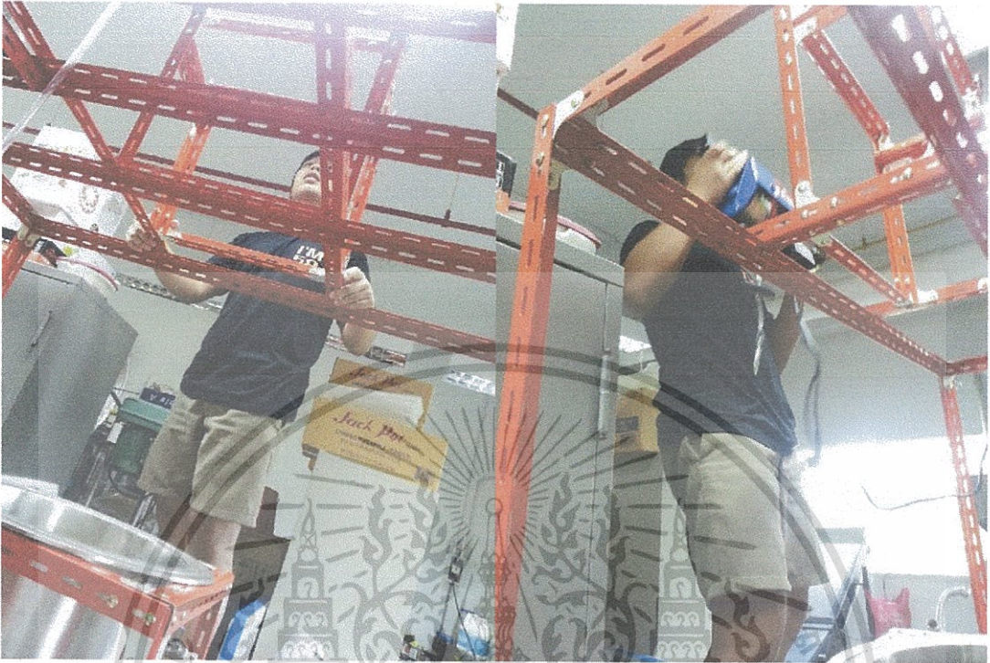
ภาพที่ ก.2.3 ทำการติดตั้งรอกไฟฟ้า
