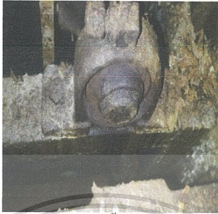
ภาพที่ 3.6 ภาพแบร้งในกระบวนการการปรับปรุงพื้นผิว (Surface treatment) ก่อนการแก้ไข
