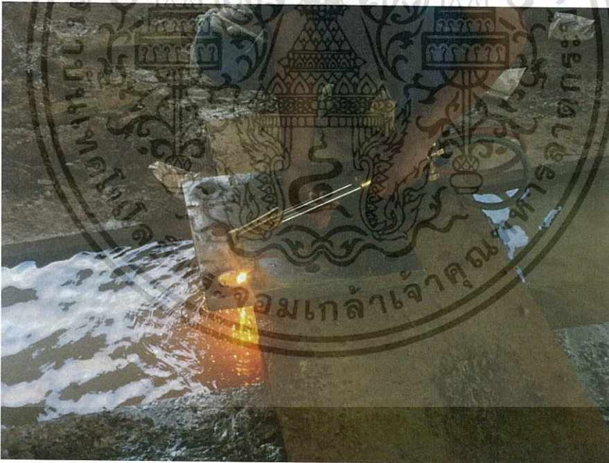
ภาพที่ ๓.4 การคว้านรูแผ่นฐานด้วยแก๊ส
