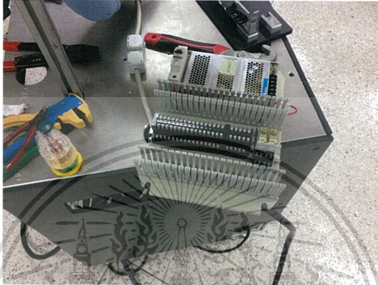
ภาพที่ 3.4 การติดตั้งอุปกรณ์ทางไฟฟ้าบนตู้ควบคุม
