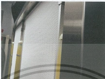
ภาพที่ 2.15 แสดง ULPA Filter สำหรับกรองอากาศก่อนป้อนอากาศสู่พื้นที่ทำงาน
