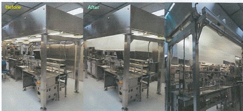
ภาพที่ 3.13 แสดง ลามินาร์ที่ติดตั้งม่านกันอากาศ
