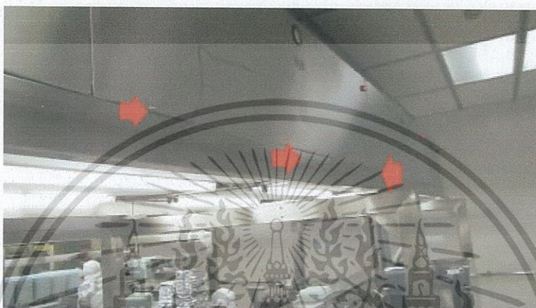
ภาพที่ 3.6 แสดง การติดเส้นด้ายเพื่อสังเกตลักษณะของอากาศด้านนอกที่ออกจากลามินาร์
