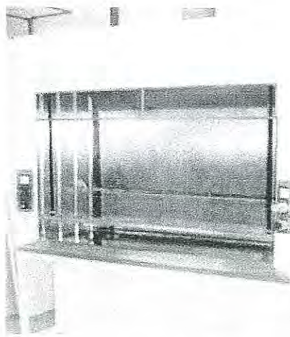
ภาพที่ 2.5 ตัวอย่างการติดตั้งตู้ดูดควันแบบถาวร ที่มา : นิตยสารสถาบันส่งเสริมวิทยาศาสตร์และเทคโนโลยี (2553 : 3)
