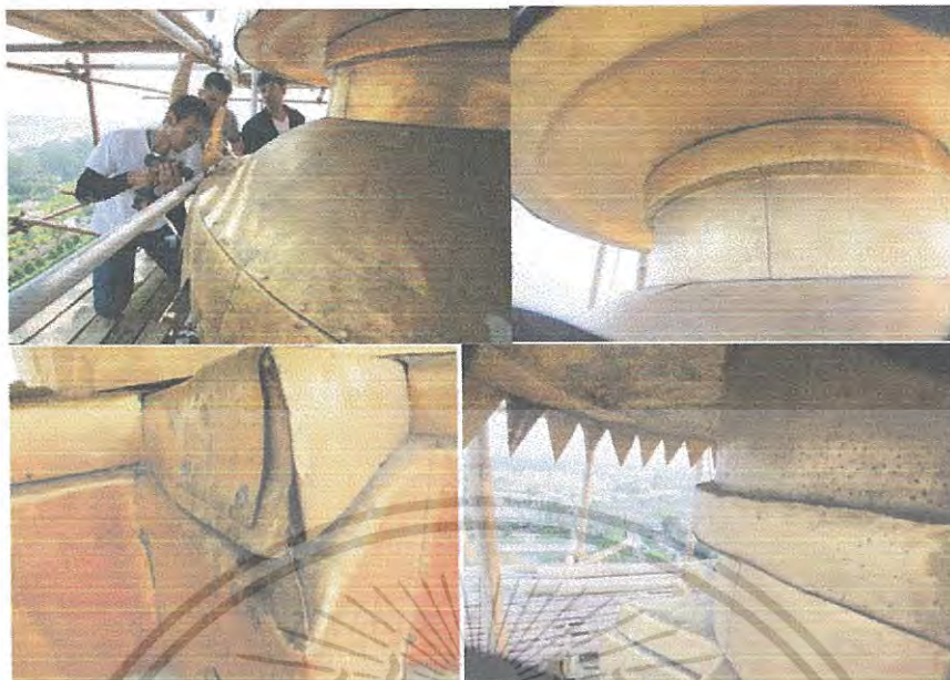
ภาพที่ 2.18 วัสดุที่ทำเป็นโลหะทองแดงทาทองและปิดทองคำเปลว ที่มา : ภาพโดย สำเนียง หนูคง 2556
