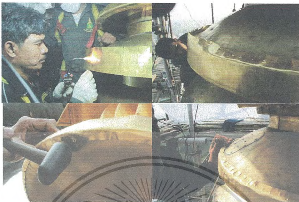
ภาพที่ 2.99 การบุหุ้มติดตั้งขอบฉัตรชั้นที่ 2,3, 4, 5, 6 และ 7 ที่มา :ถ่ายโดย สำเนียง หนูคง (2556)
