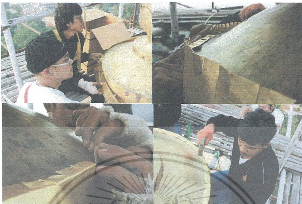
ภาพที่ 2.103 การบุหุ้มติดตั้งขอบฉัตรชั้นที่ 8
