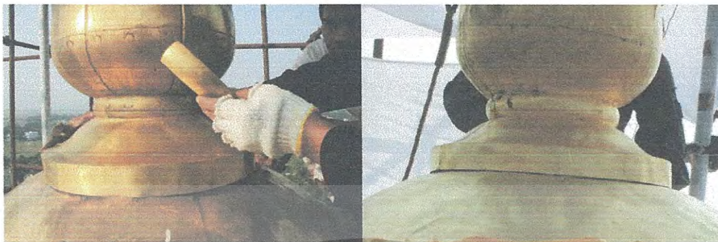
ภาพที่ 2.107 การบุหุ้มติดตั้งลูกแก้ว
