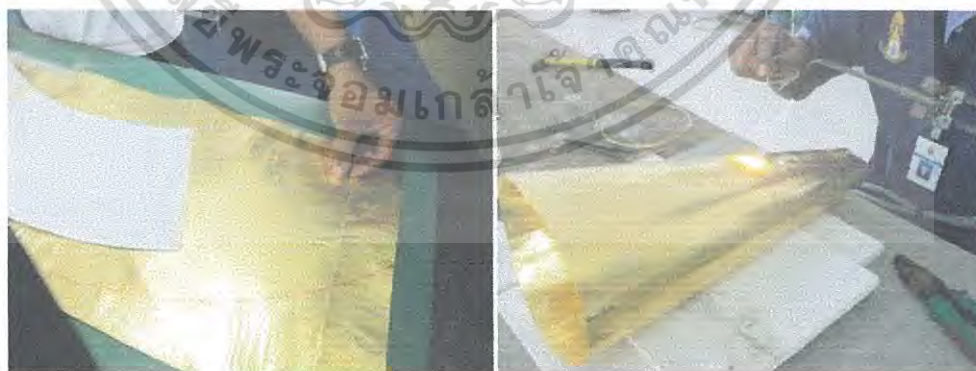
ภาพที่ 2.55 บัดกรีเชื่อมรอยต่อปลียอด
