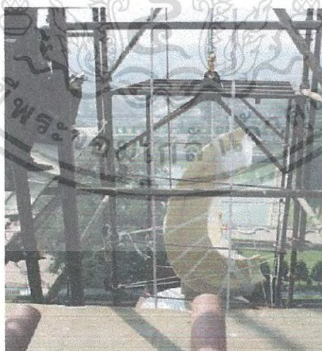
ภาพที่ จ9 การส่งชิ้นงานจากห้องเก็บพักเพื่อนำไปประกอบบนยอดเจดีย์โดยการยกด้วยการชักรอก ขึ้นด้านบนเจดีย์เพื่อประกอบแต่ละส่วนของฉัตร
