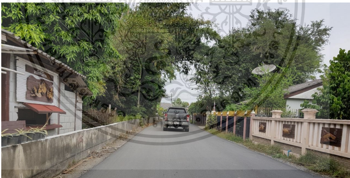
รูปที่ 5. 38 แนวพังกันน้ำบริเวณตำบลดอนแก้ว อำเภอสารภี จังหวัดเชียงใหม่
