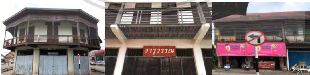
รูปที่ 5.3 อาคารแถวค้าขาย
