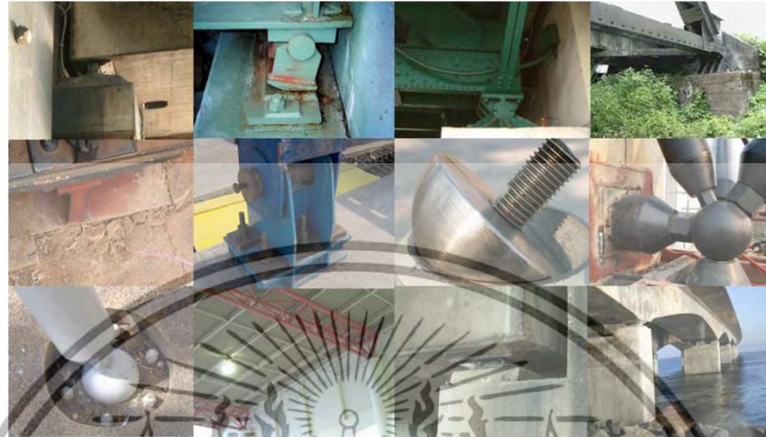
(ข)แบบยึดหมุนเคลื่อนที่ไม่ได้(Hinge or Pin Support)
