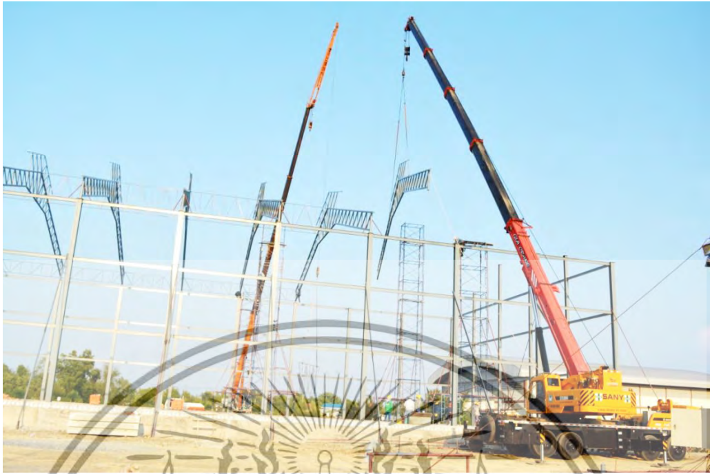
ภาพที่ 4.29 การติดตั้งโครงหลังคาอาคาร 1 โครงการA (วันที่ 1) ที่มา : ผู้วิจัย
