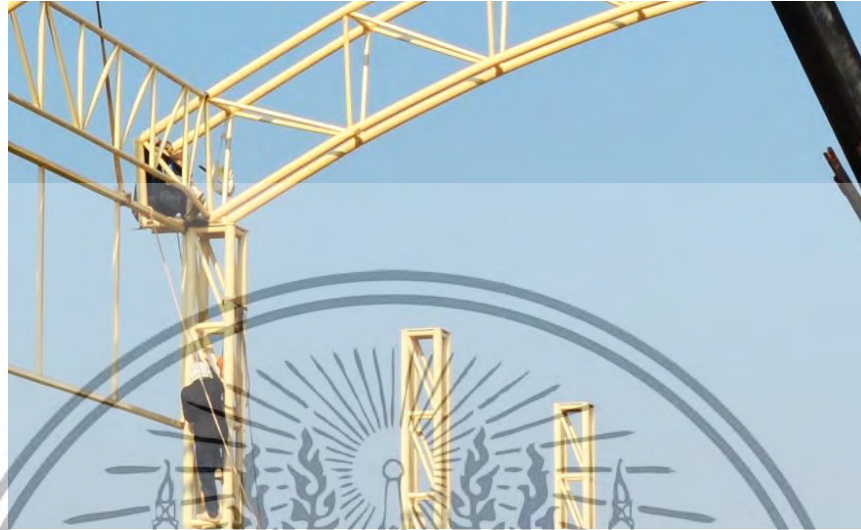
ภาพที่ 5.5 แสดงการป็นเสาโครงถักสามมิติเพื่อขึ้นไปทำการติดตั้งโครงหลังคา ที่มา : ผู้วิจัย
