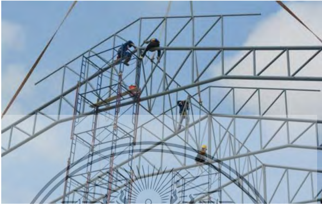
ภาพที่ 4.8 ช่างติดตั้งขณะปฏิบัติงานโครงการ A ที่มา : ผู้วิจัย
