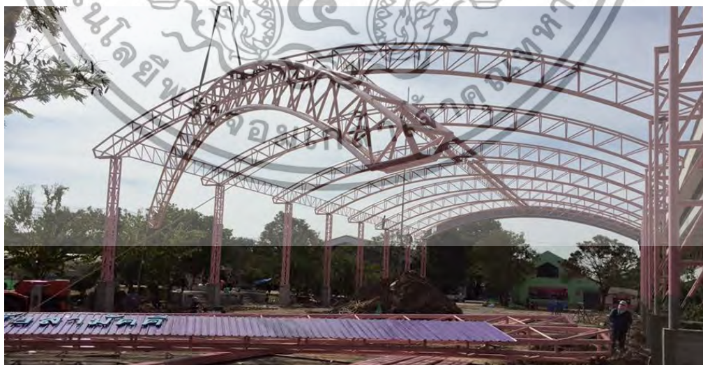
ภาพที่ 4.52 ทีมช่างติดตั้งกำลังดำเนินการติดตั้งโครงหลังคา โครงการ B ที่มา : ผู้วิจัย
