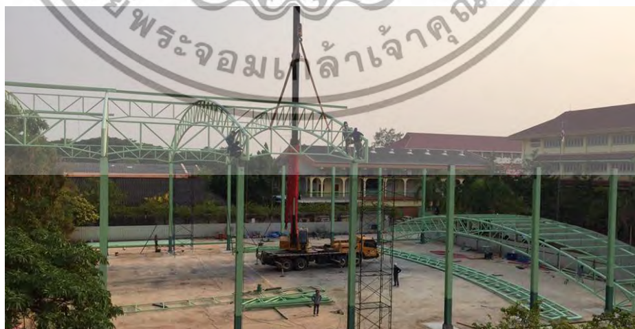
ภาพที่ 5.2 แสดงการติดตั้งชิ้นส่วนด้วยเครน 1 คัน
