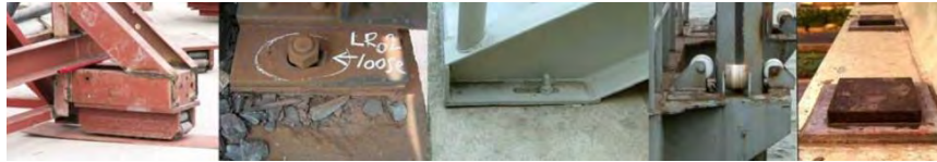
(ก) แบบยึดหมุนเคลื่อนที่ได้(Roller Support)
