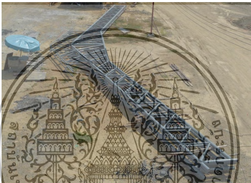
ภาพที่ 5.6 การกองเก็บชิ้นส่วนแบบไม่มีการกำหนดรหัสในการติดตั้ง ที่มา : ผู้วิจัย
