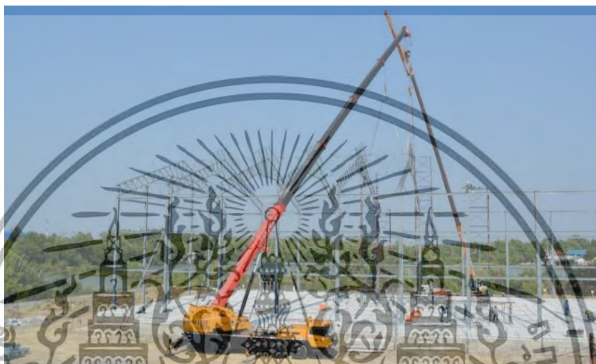
ภาพที่ 5.1 แสดงการติดตั้งชิ้นส่วนด้วยเครน 2 คัน
