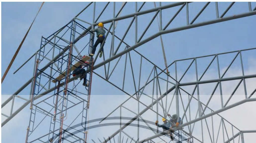
ภาพที่ 4.19 ทีมช่างติดตั้งขึ้น-ลงนั่งร้านเพื่อขึ้นไปเชื่อมติดตั้งโครงหลังคาอาคาร 1 โครงการ A ที่มา : ผู้วิจัย
