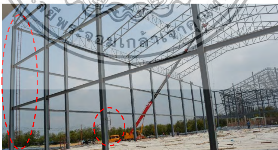
ภาพที่ 5.4 บันไดลิงที่ใช้ในการปีนขึ้นไปติดตั้งโครงหลังคาอาคาร 2 โครงการ A ที่มา : ผู้วิจัย
