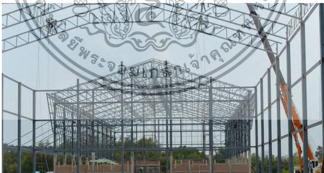
ภาพที่ 4.20 ทีมช่างติดตั้งได้ตามโครงสร้างอาคารเพื่อเชื่อมติดตั้งโครงหลังคาอาคาร 2 โครงการ A ที่มา : ผู้วิจัย
