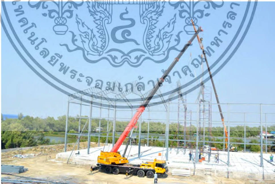
ภาพที่ 4.28 การจัดวางเครนอาคาร 1โครงการAในด้านตรงกันข้ามมีรวดเร็วในการทำงานเพิ่มขึ้น ที่มา : ผู้วิจัย
