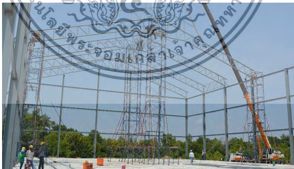
ภาพที่ 4.15 นั่งร้าน 2 ขนาด ที่ช่างติดตั้งใช้ในการขึ้นติดตั้งโครงหลังคาอาคาร 1 โครงการ A
