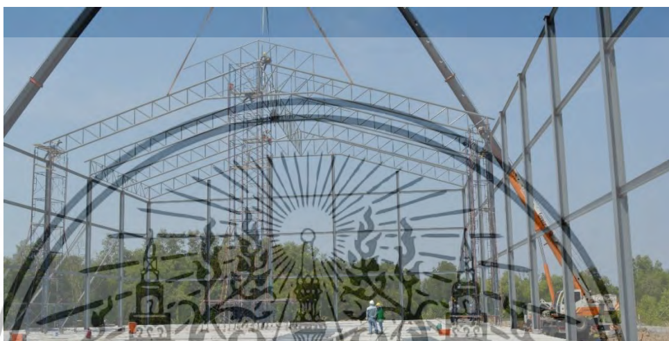
ภาพที่ 5.3 แสดงการใช้นั่งร้านในการขึ้นไปติดตั้งกรณีศึกษาอาคาร 1 โครงการ A ที่มา : ผู้วิจัย
