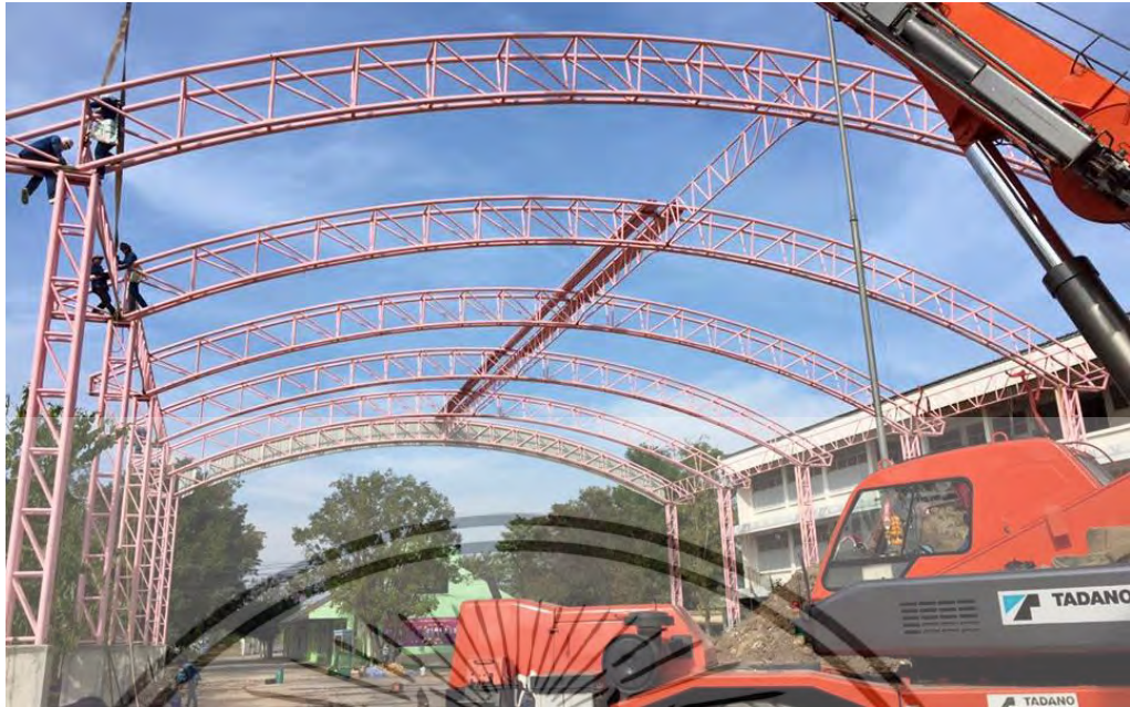
ภาพที่ 4.43 ภาพช่วงติดตั้งขณะกำลังปฏิบัติงานโครงการ B ที่มา : ผู้วิจัย
