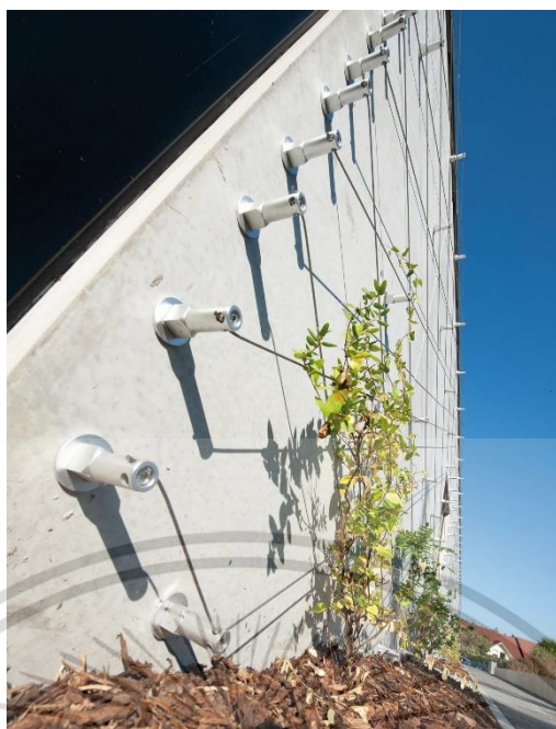
ภาพที่ 2.3 ตัวอย่างของระบบฟาซาดระแนงติดผนัง ที่มา : https://bit.ly/2DV1Aiv
