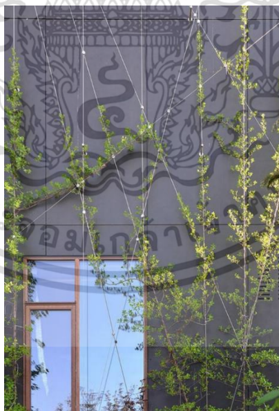
ภาพที่ 2.6 ตัวอย่างของระบบตาข่ายลวดสลิงและตาข่ายเคเบิล (Cable and wire-rope net system)
