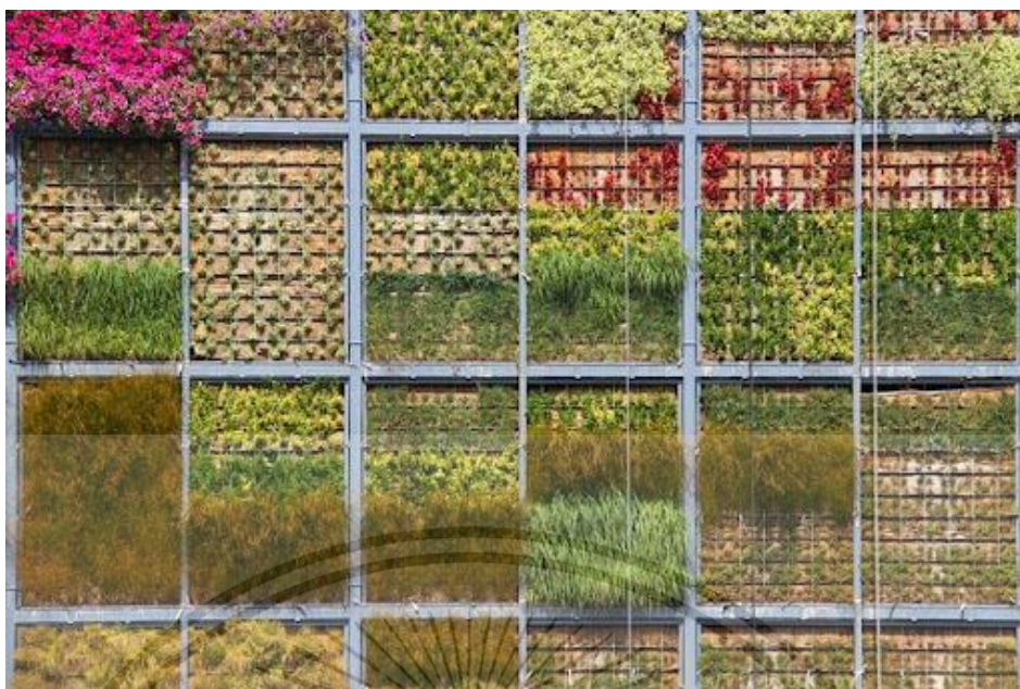
ภาพที่ 2.13 ภาพประกอบของระบบกล่องของสวนแนวตั้งแบบโมดูลาร์
