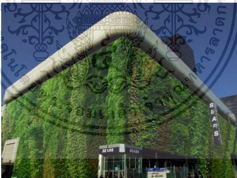
ภาพที่ 2.14 ภาพประกอบของระบบกำแพงแผ่นชั้นพืช
