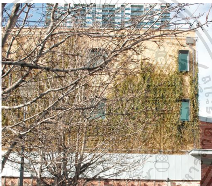
ภาพที่ 2.8 Green Facade ของอาคาร Building 21 มหาวิทยาลัย RMIT
