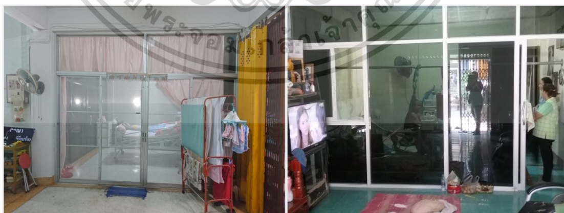
ภาพที่ 4.69 การติดตั้งผนังเบา ในส่วนดูแลผู้สูงอายุ
