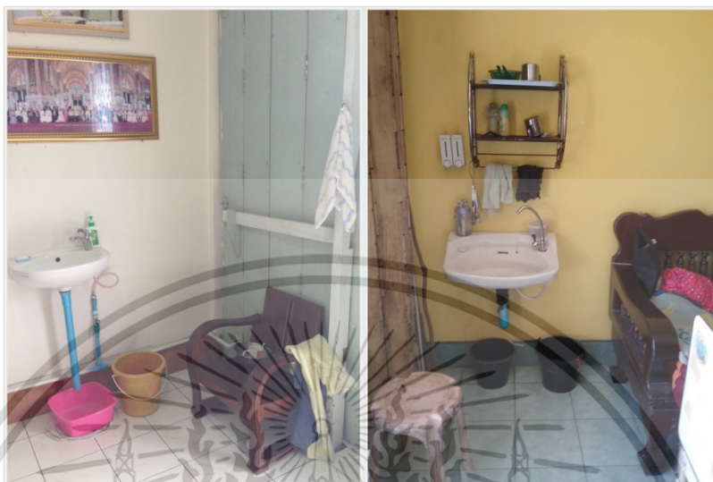
ภาพที่ 4.66 การย้ายหรือติดตั้งอ่างล้างมือใหม่ บริเวณเตียงผู้สูงอายุ
