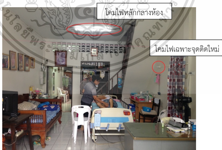
ภาพที่ 4.67 การติดตั้งโคมไฟเฉพาะจุด บริเวณเตียงผู้สูงอายุ
