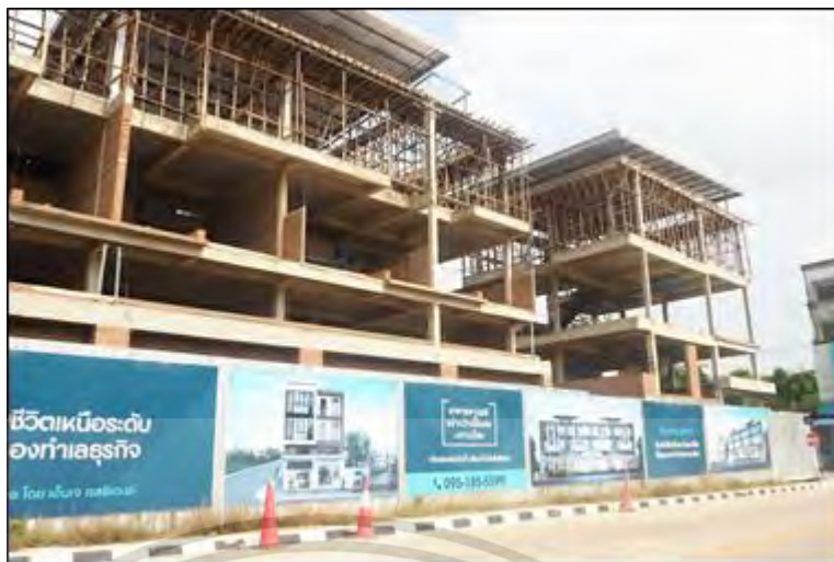
ภาพที่ 5.3 การก่อสร้างอาคารพาณิชย์ภายในโครงการ
