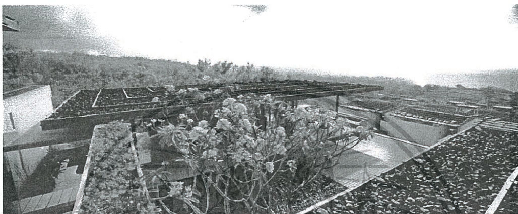
รูปที่ 3.45 แสดงหลังคาที่ทำจากวัสดุหินภูเขาไฟ
