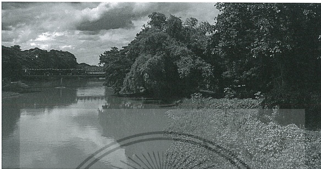
รูปที่ 3-6 แสดงพื้นที่รวมแม่น้ำกวงของที่ตั้งโครงการที่ 1
