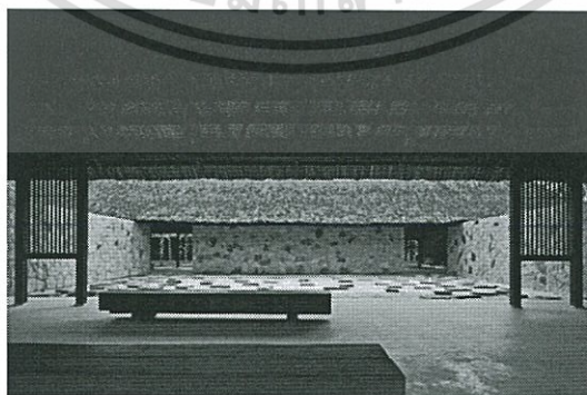
รูปที่5- 24 ภาพบรรยากาศแสดงให้เห็นส่วนโครงสร้างหลังคา
