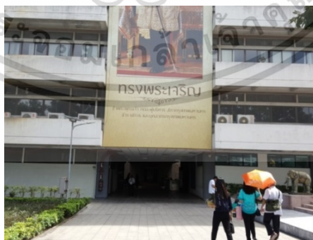
ภาพที่ 4.6 ทางเข้าหลักของอาคารสำนักงานสำนักงานโยธาจากด้านทิศตะวันตกของอาคาร
