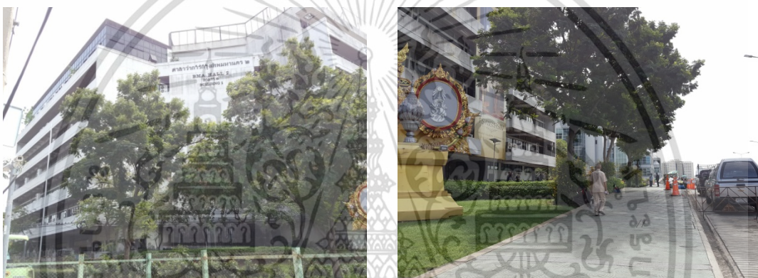
ภาพที่ 4.5 ด้านหน้าอาคารสำนักงานสำนักงานโยธาจากทิศตะวันตกของอาคาร
