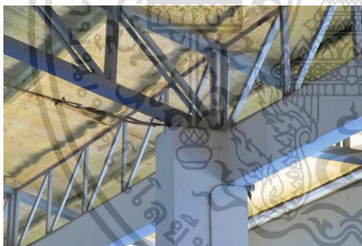
รูปที่ 4.43 จุดต่อโครงสร้างอาคารสนามกีฬาในร่ม 1 สจล.
