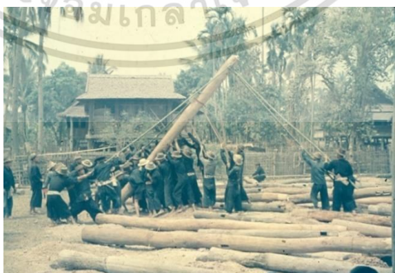
รูปที่ 2.8 แสดงการปักเสาเฮินของชาวไทลื้อในอำเภอเชียงคำ จังหวัดพะเยา
