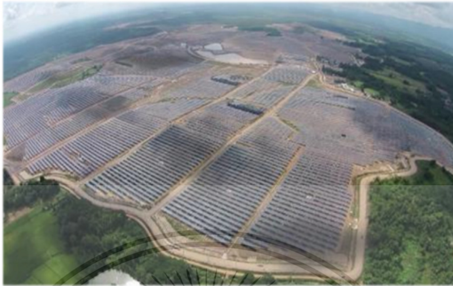
รูปที่ 2.22 โรงไฟฟ้าพลังงานแสงอาทิตย์
