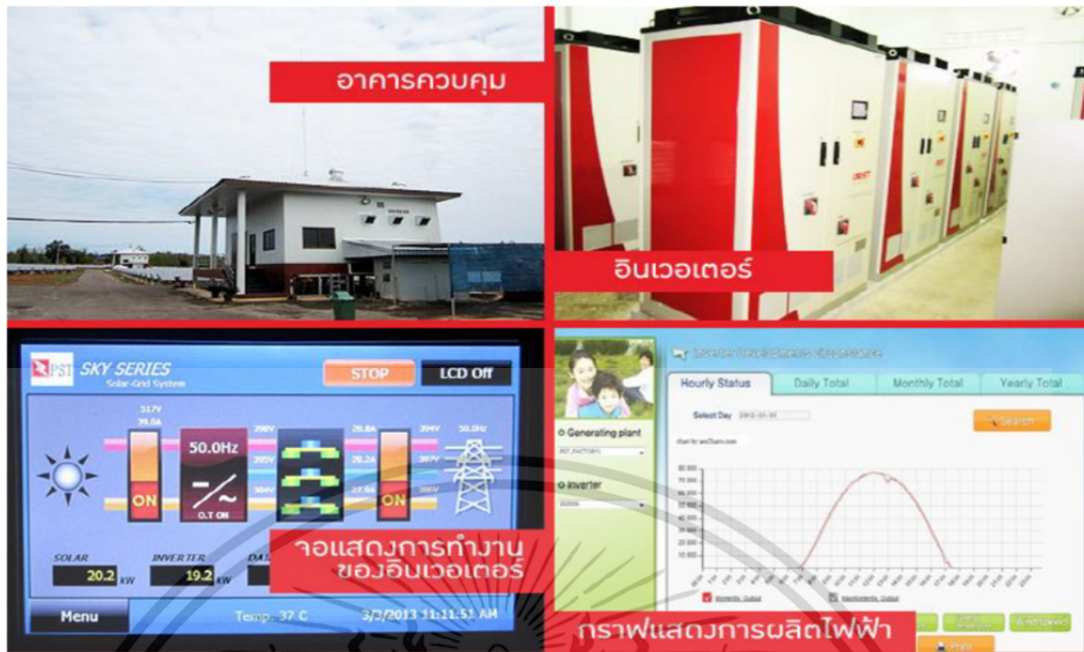
รูปที่ 2.24 การควบคุมโรงไฟฟ้าพลังงานแสงอาทิตย์
