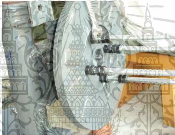
รูปที่ ก. 11 ชันยึดด้วยเหล็กเกลียวตลอดให้ครบทั้ง 4 ตัว
