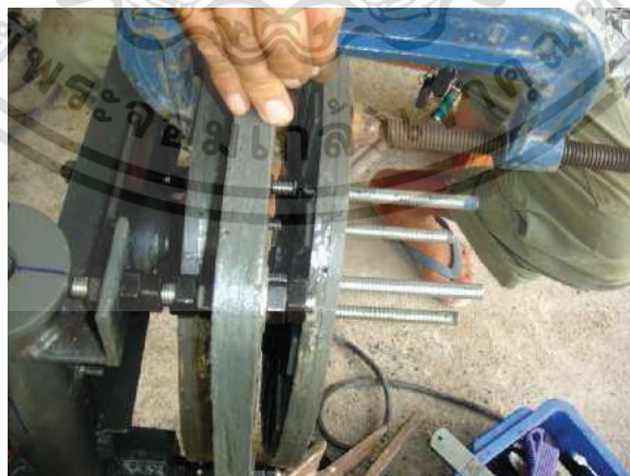
รูปที่ ก. 12 ทำการปรับระยะห่างระหว่างชุดแม่เหล็กที่ 2 และชุดสเตเตอร์ แล้วขันน็อตยึดให้แน่น
