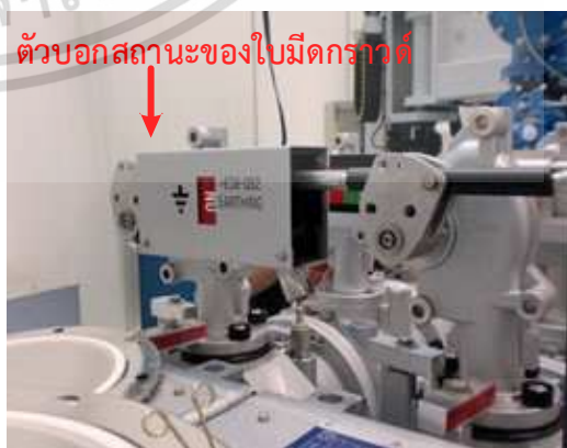
รูปที่ 2.8 ใบมีดกราวด์ใน GIS AREVA B65 115kV
