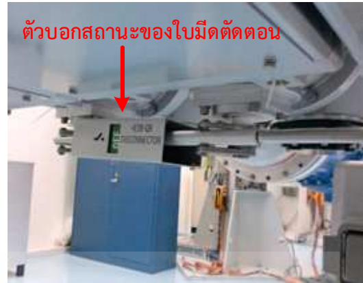
รูปที่ 2.7 ใบมีดตัดตอนใน GIS AREVA B65 115kV
