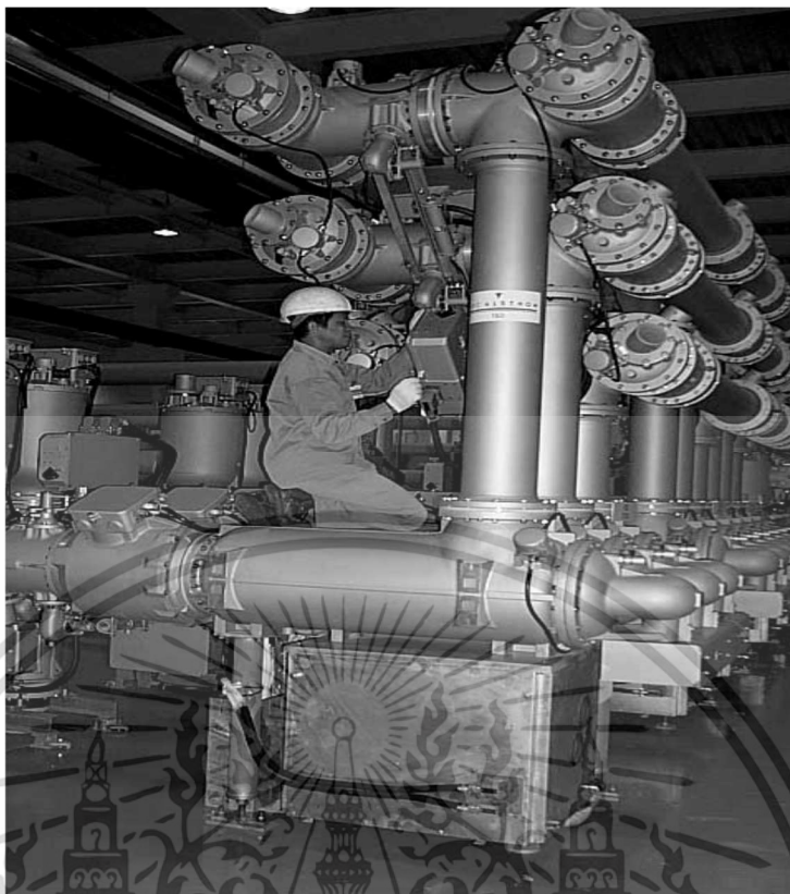
รูปที่ 2.5 การระบายแรงดันเกินในระบบ GIS [1]
