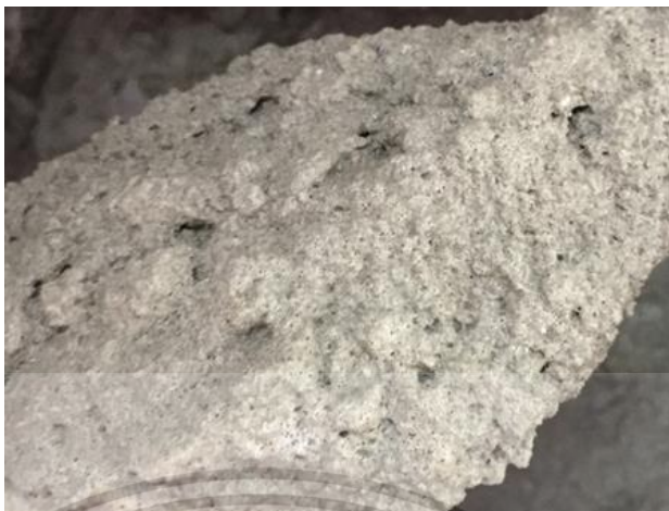
รูปที่ 4.8 ฟองอากาศขนาดเล็กแทรกภายในเนื้อคอนกรีตสด
