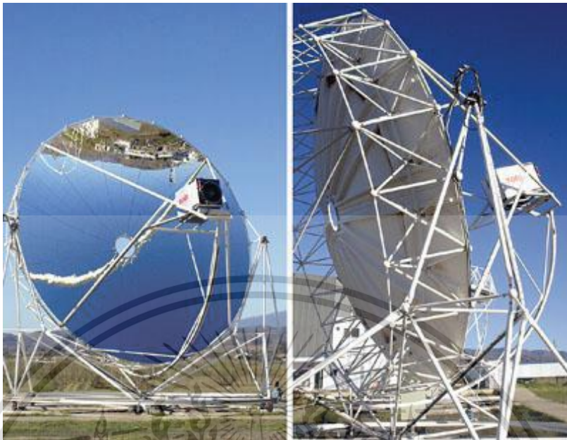
รูปที่ 3.40 งานรวมแสงพาราโบลิกที่ใช้งานร่วมกับเครื่องยนต์สเตอร์ลิงของโครงการ EUROdish [29]
