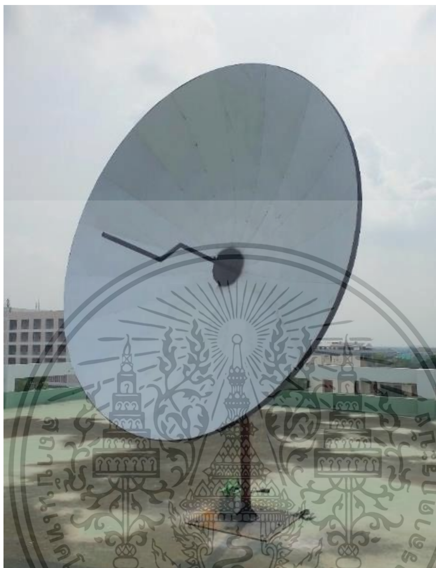
รูปที่ 4.5 โครงสร้างงานรับสัญญาณดาวเทียมก่อนการติดตั้งชุดสะท้อนแสง
