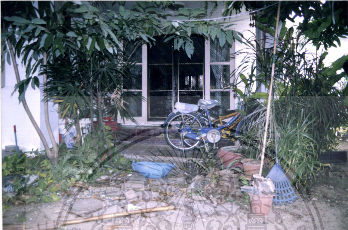
ภาพที่ 8 แสดงภาพถ่ายพื้นที่ส่วนA เดิมเป็นลานจอดรถจักรยานที่ระดับพื้นเกิดการทรุดตัวลง
