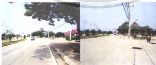
ภาพที่ 1.6 แสดงทิศเหนือ ด้านนี้เป็นทางเข้าของโครงการซึ่งติดถนนมาลัยแมน-สุพรรณฯ
