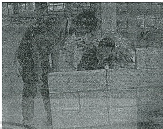
รูปที่ (29) แสดง การก่อผนังคอนกรีตมวลเบา
