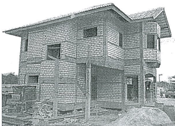
รูปที่ (28) แสดง โครงสร้างบ้านที่ก่อผนังด้วยคอนกรีตมวลเบา
