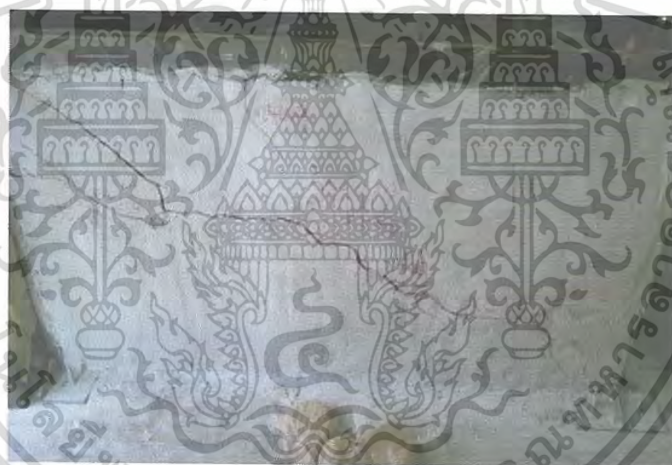
รูปที่ 3.13 แสดงการแตกร้าวของกำแพงอิฐมวลเบาเต็มช่อง
