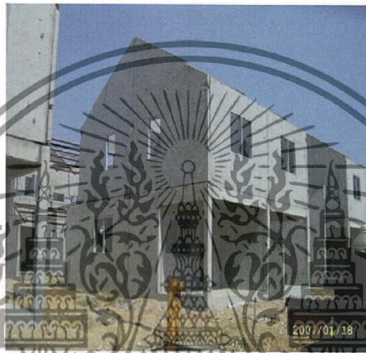
รูปที่ 2.2 โครงสร้างระบบผนังรับแรง สภาวิศวกร 2556
