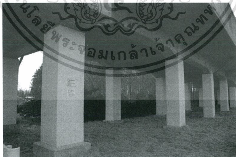
รูปที่ 2.8 การหุ้มด้วยแผ่นเหล็ก (มยผ.1303-57, กรมโยธาธิการและผังเมือง, กระทรวงมหาดไทย, 2557)
