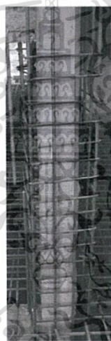
รูปที่ 2.9 การหุ้มหน้าตัดด้วยคอนกรีตเสริมเหล็ก
