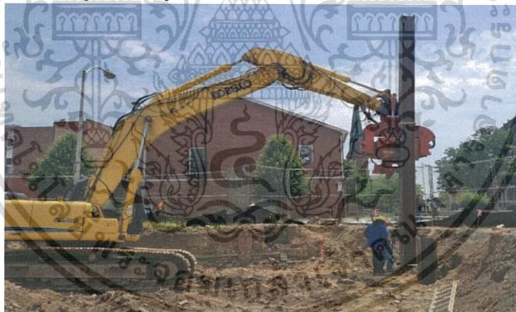
รูปที่ 2.7 รูปแสดงปั้นจั่นแบบ Vibratory Hammer
