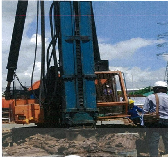
ก.4 ภาพแสดงลักษณะการติดตั้งของเสาเข็มและลูกตุ้มที่ใช้ตอก
