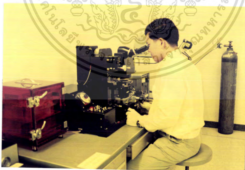
เอกสารนี้เป็นเอกสารที่สงวนไว้สำหรับการใช้งานเพื่อการศึกษาเท่านั้น ไม่อนุญาตให้นำไปใช้ประโยชน์ด้านการค้า ไม่ว่ากรณีใดๆ ทั้งสิ้น รูปที่ ๓-4 แสดงภาพถ่ายอุปกรณ์ที่ใช้ในการถ่ายมาสก์ (Mask aligner) ครั้งที่มีการนำไปใช้
