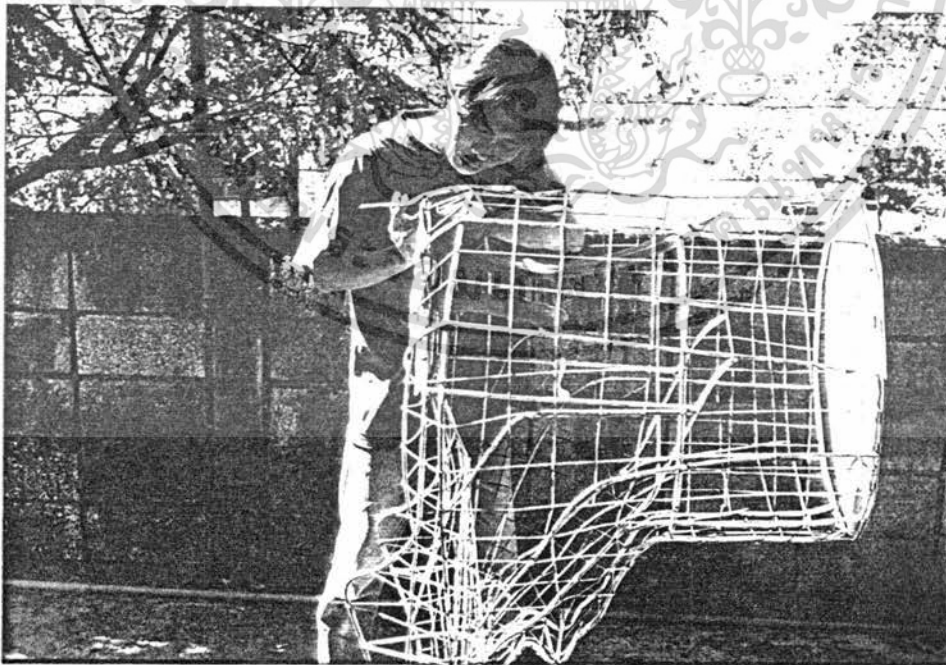
ภาพการประกอบพิมพ์ยางเข้ากับโครงเหล็ก
