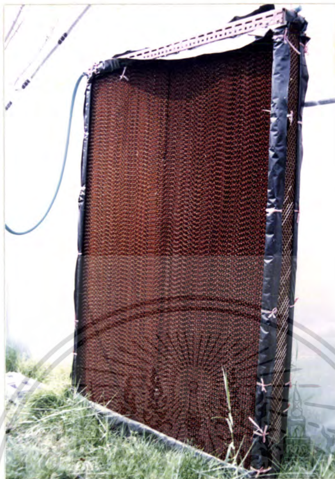
ภาพที่ 15 แสดงการติดตั้งแผ่น CELdek บริเวณด้านหลัง Greenhouse
