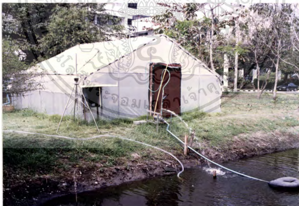
ภาพที่ 12 แสดงด้านหลังของ Greenhouse และการติดตั้งระบบ EVAP
