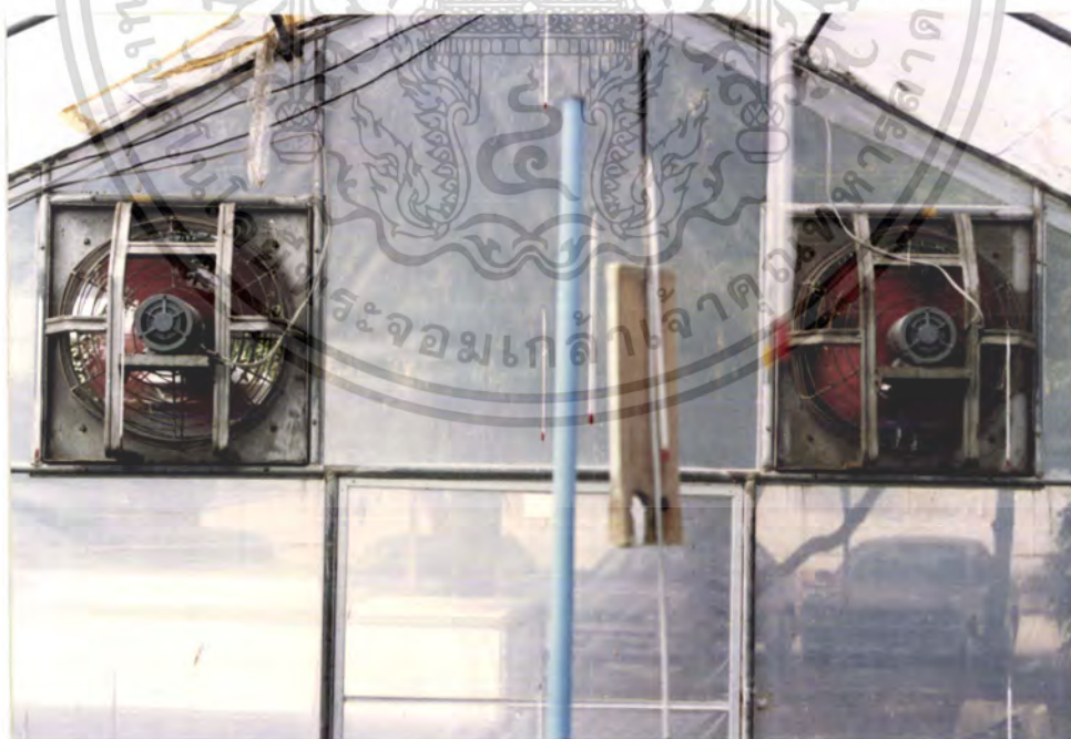
ภาพที่ 16 แสดงการติดตั้งพัดลมระบายอากาศทั้ง 2 เครื่องบริเวณด้านหน้า Greenhouse ทั้งด้านซ้ายและด้านขวา
