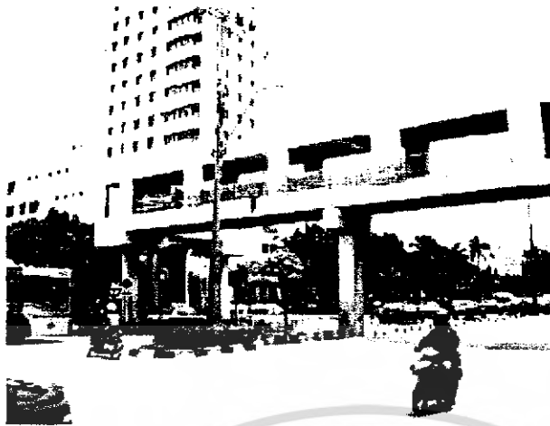
D บริเวณคานบางของสะพาน ลอย
