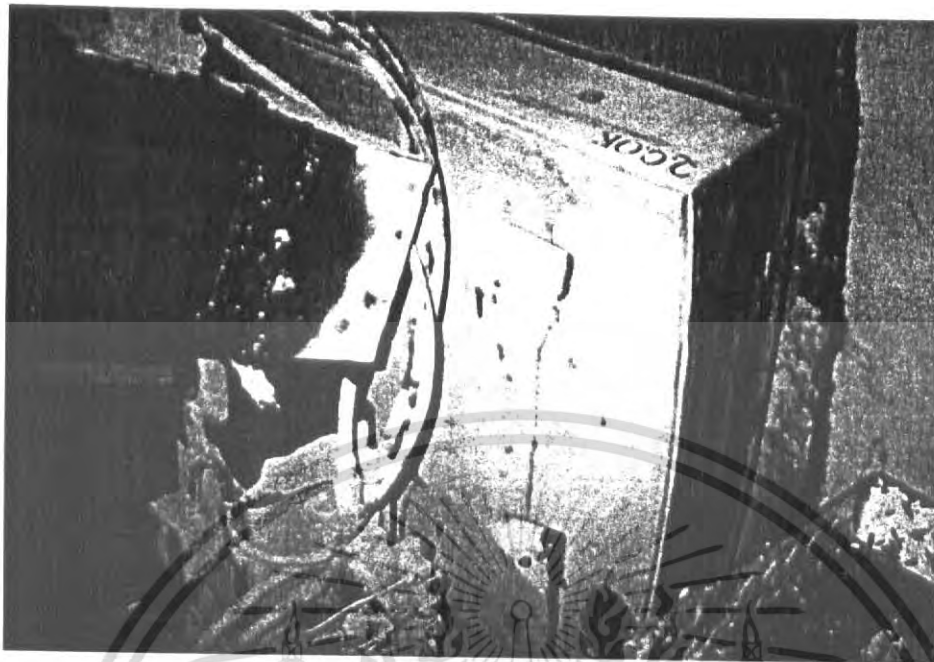
รูปที่ 4.48 แขนเครื่องติดตั้งผนังอุโมงค์ ติดตั้งผนังอุโมงค์ตามตำแหน่งที่ได้ออกแบบไว้
