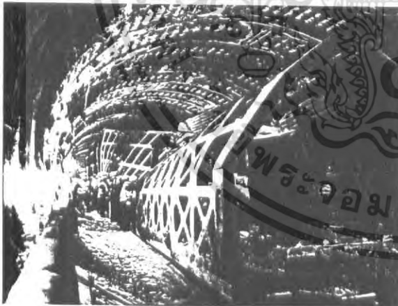
รูปที่ 4.149 ความเสียหายจากไฟไหม้ในอุโมงค์ Euro Tunnel
