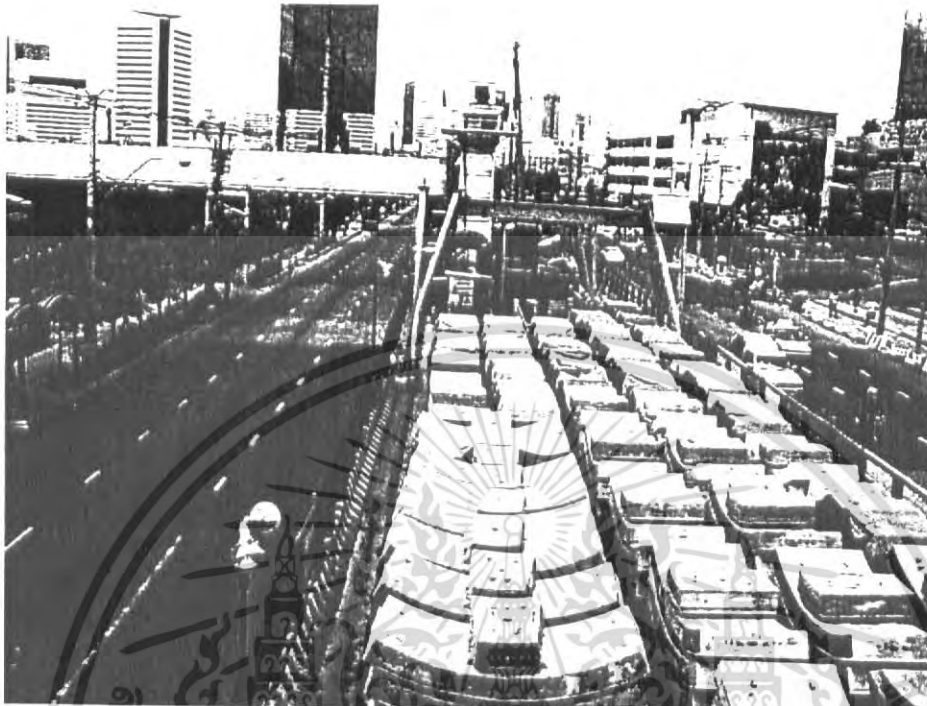
รูปที่ 4.45 การจัดเก็บผนังอุโมงค์ (Bangkok-MRTA, Thiam Ruam Mit Station)
