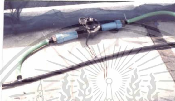
ภาพที่ 3 แสดงการติดตั้ง Solinoid valve
