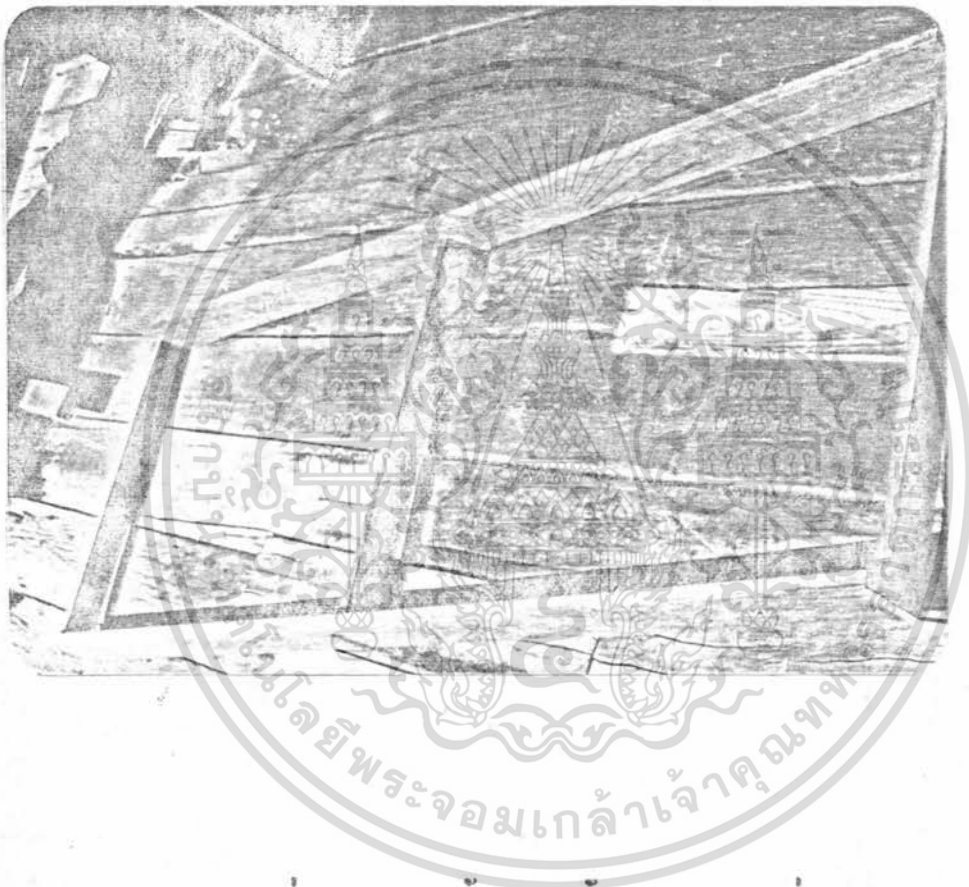
ภาพที่ 4 โครงสร้างรอบคานนอกของตัวกล่องหลังจาก เข้าหัวไม้เรียบร้อยแล้ว
