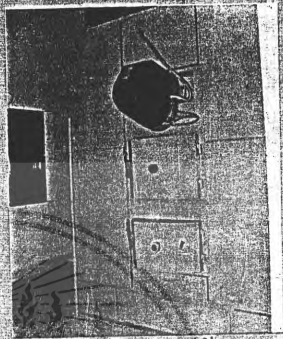
บริเวณหลังเตา พร้อม หัวเผาใหญ่, ช่องเก็บกระดูก และช่องสังเกต การเผาไหม้
