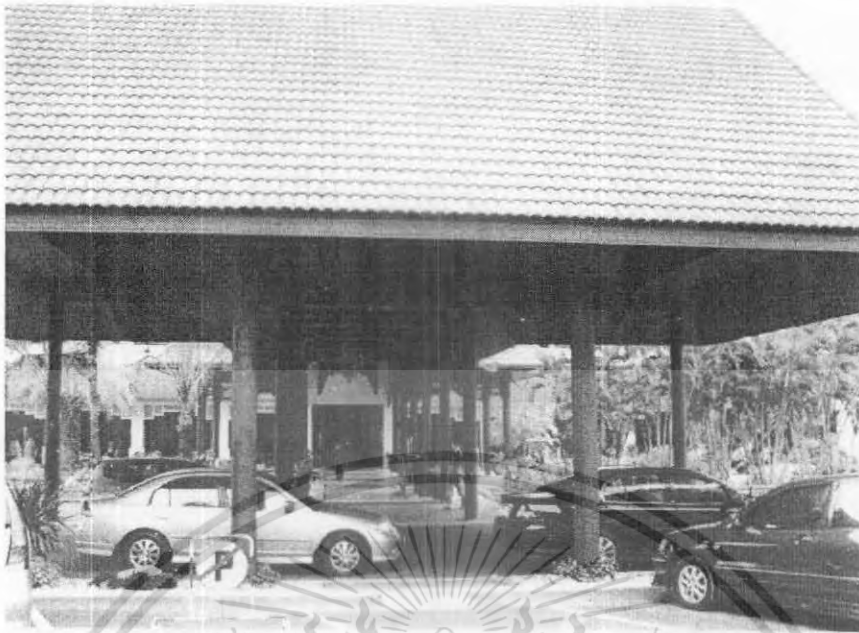
รูปภาพ 1.8 ทิศตะวันออก : LOBBY โครงการเค็ม
