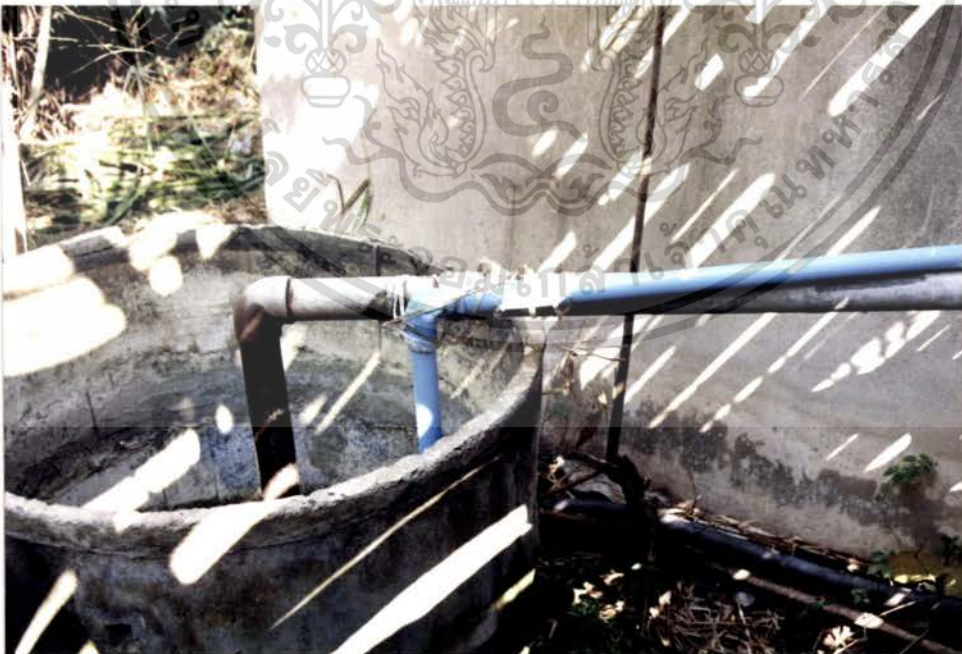
ภาพที่ 20 แสดงท่อน้ำส่งน้ำ จะส่งน้ำจากบ่อพักน้ำไปที่แผงระเหยน้ำ
