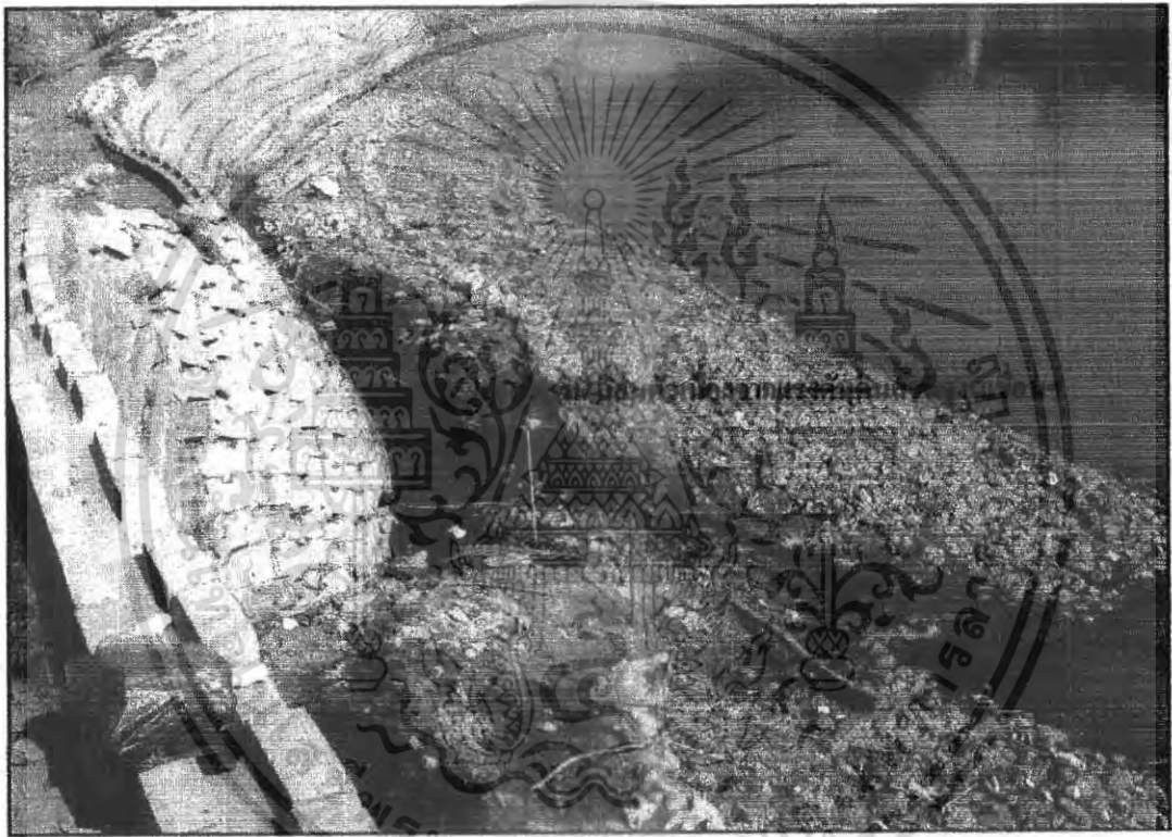
รูปที่ 4-12 แนวเคลื่อนแยกระหว่างฐานเชื่อมกับกำแพงกันดิน
