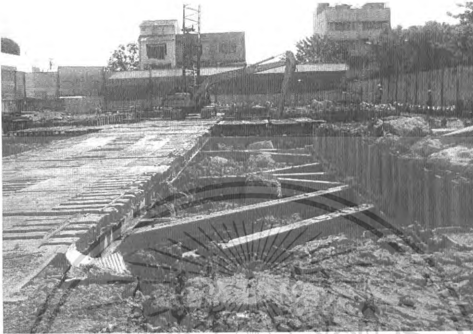
รูปที่ 3.13. แสดงภาพการขุดดินออกจนต่ำกว่าระดับ bracing ชั้นที่ 2 ประมาณ 50 เซนติเมตร
