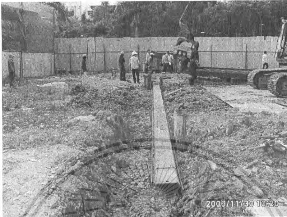
รูปที่ 3.2 แสดงการนำ sheet pile มาวางเป็นแนวเพื่อทำการตอก
